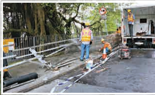
►工人在薄扶林道車禍現場維修
