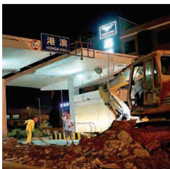
▲深圳交委開始拆除全市16個二線關口的車檢通道查驗設施。圖為南頭檢查站車檢通道拆除作業現場
