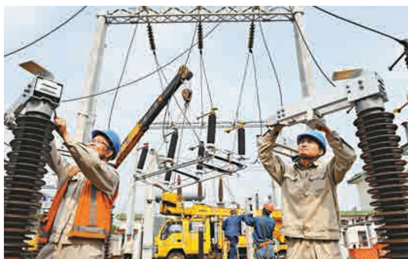
▲國家電網無錫供電公司職工在110千伏錢橋變電站安裝設備
