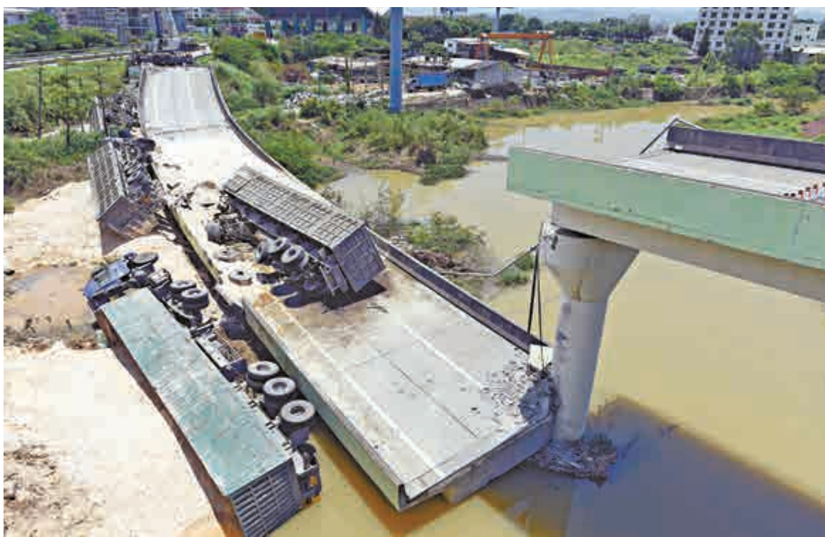
▲出事的高架橋和4輛滿載盜土的重型貨車掉落地面
