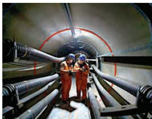
▲國務院要求，在城市建造用於集中敷設電力、通信、給排水、熱力、燃氣等市政管線的地下綜合管廊。圖為蘇州工業園區的地下管廊 新華社
