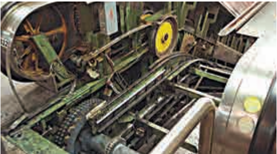
▲扶手電梯構造複雜，分為支撐結構，梯級、扶手帶、摩打等 網上圖片
