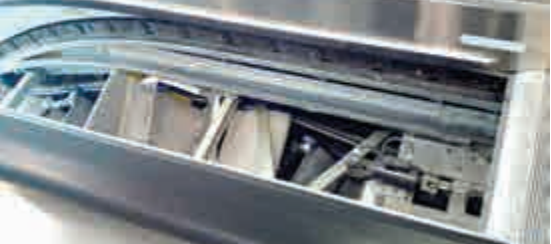
▲梯級受擠壓爆開，釀成「炒電梯」意外 網上圖片
