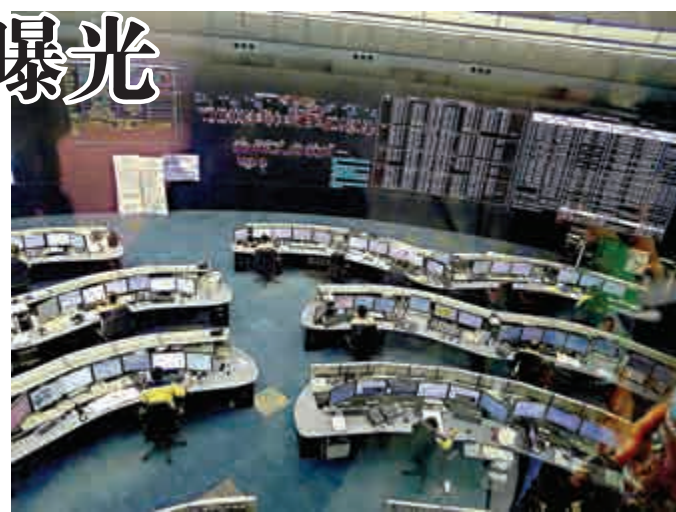
▲青衣站港鐵車務控制中心運作情況
