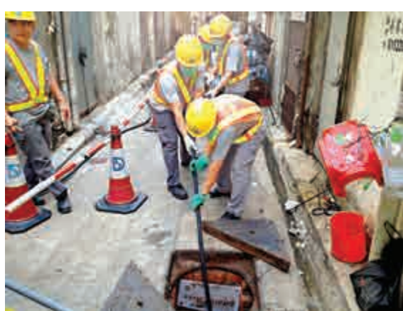
▲清潔人員先將高壓水管塞入沙井，然後開水通渠，工序歷時約30分鐘
