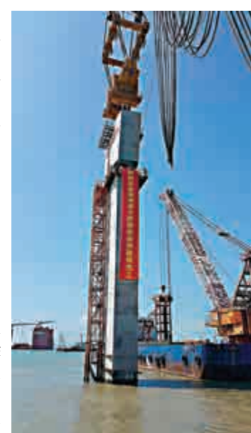
▲港珠澳大橋全線208座墩台全面竣工 大公報記者方俊明攝
