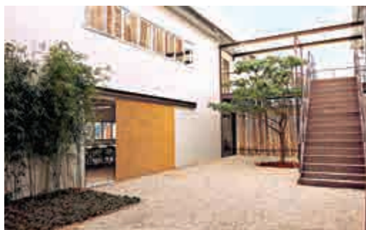
▲工地辦公室利用回收的建築物料配合環保設計
