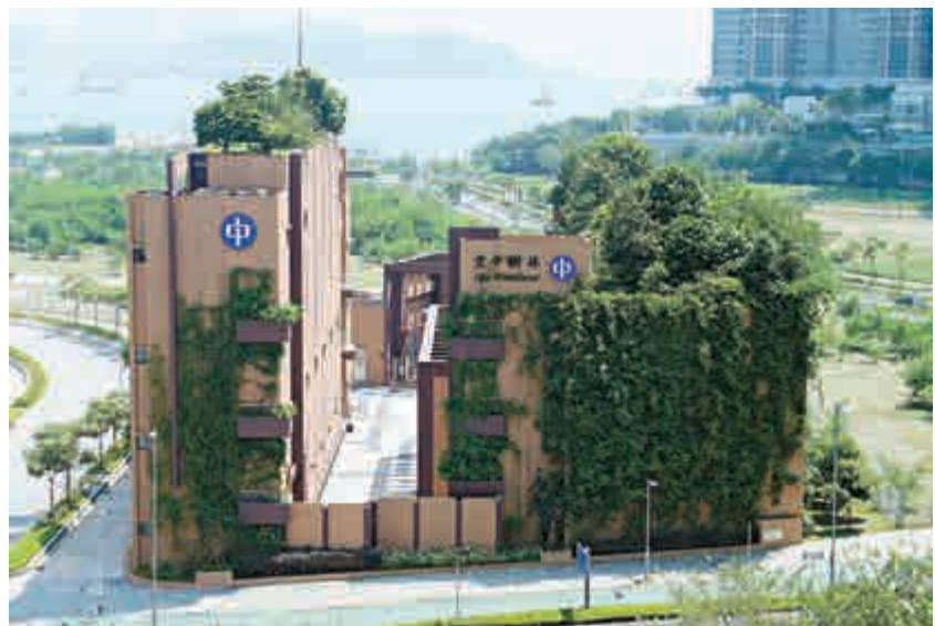
▲中電翠嶺路電站的「空中樹林」 大公報記者林良堅攝
