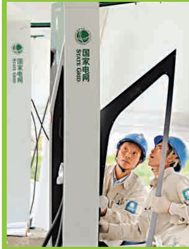
▲3日，工程人員在京滬高速江蘇揚州汜水服務區新建的電動汽車充電站內安裝充電樁 ▲位於北京華貿寫字樓的電動汽車交流電充電區
