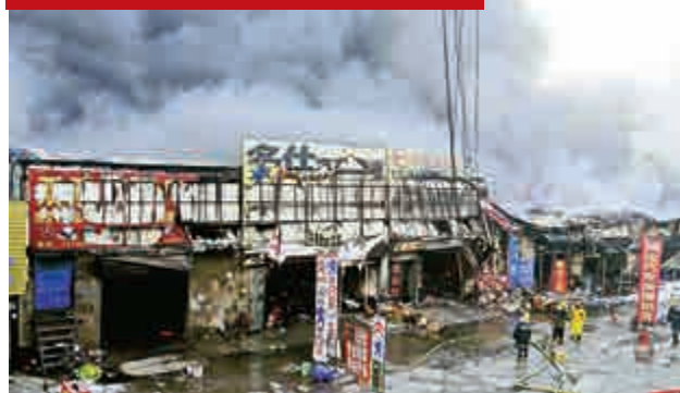
10月9日下午15時55分左右，位於徐州市泉山區淮海汽車城門面房發生火災，徐州消防指揮中心立即調派周邊5個消防中隊13輛消防車78名消防官兵趕赴現場撲救，無人傷亡，目前，火勢已基本撲滅。 中新社
