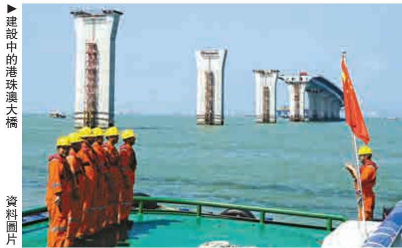
建設中的港珠澳大橋
