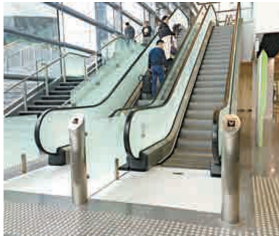
新建樓宇的大廈電梯須安裝感應器，在無人使用的情况下自動停駛 大公報記者何進昇攝
