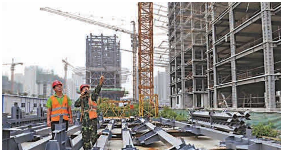
◀保障房工程跟蹤審計查出問題整改4.26萬戶。圖為河北滄州某保障房項目施工現場 資料圖片
