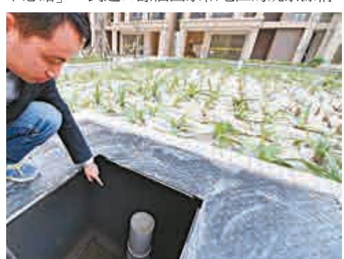
▲廈門一處雨水花園的地下儲水井 資料圖片
