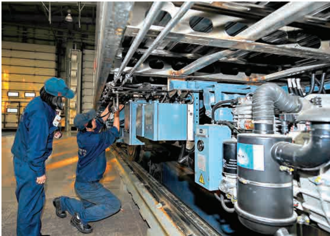
▲中車長客員工在對北京燕房線地鐵列車進行收尾作業
