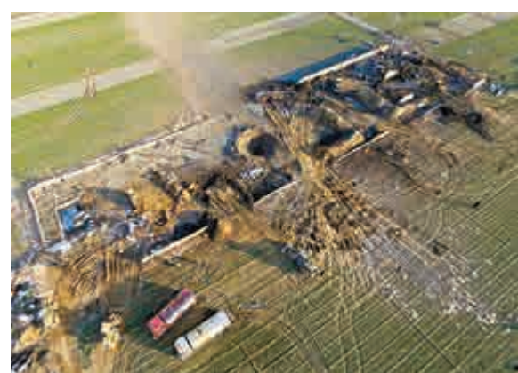
▲14日，河南通許縣一家煙花廠發生爆炸，廠房被夷為平地。中新社
