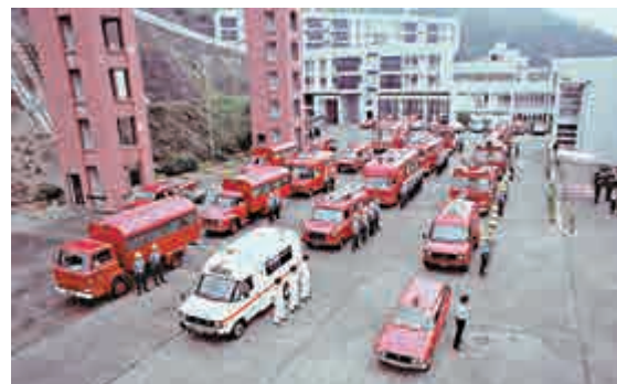
▲八鄉消防訓練學校舊貌。圖為1980年車輛檢閱 消防處提供
