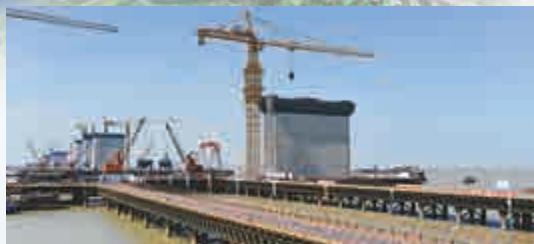
▲滬通大橋建設工地
