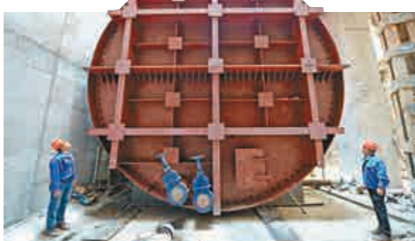
▲9日，施工人員查看地鐵隧道口工程 新華社
