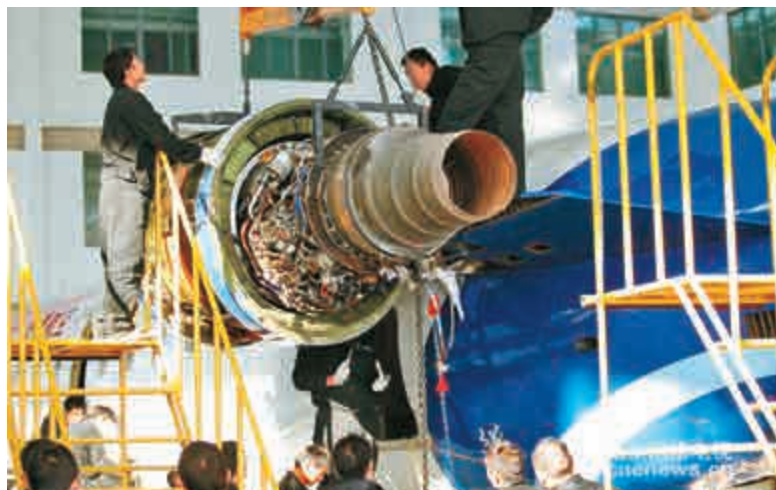
廣東省致力發展飛機維修製造業，有利於促進上下游相關產業鏈及物流產業的發展。圖為航空工程公司技術人員在機庫執行維修任務。網絡圖片
