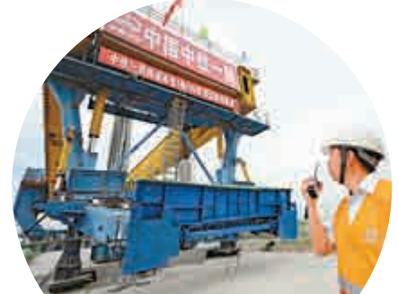
▲西安至成都高鐵箱梁架設現場 新華社
