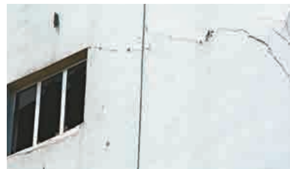
▲牆身出現裂痕，令人擔心
