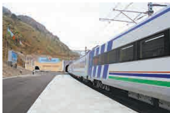
▲烏茲別克「安格連—帕普」鐵路卡姆奇克隧道正式通車 中新社
