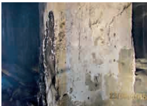
▲牆壁出現剝落及裂縫
