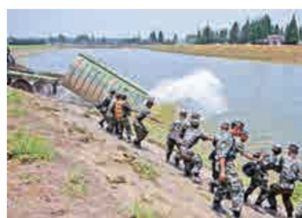
▲7月11日，湖南華容，搶險救援部隊的戰士們正在現場搭建浮橋
