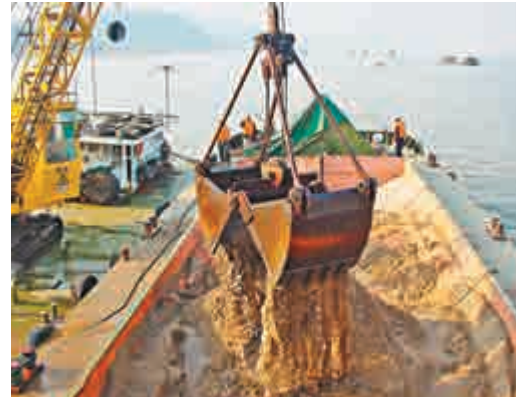
▲廣州港斥資35億元拓寬出海深水航道。圖為航道疏浚現場 大公報記者方俊明攝
