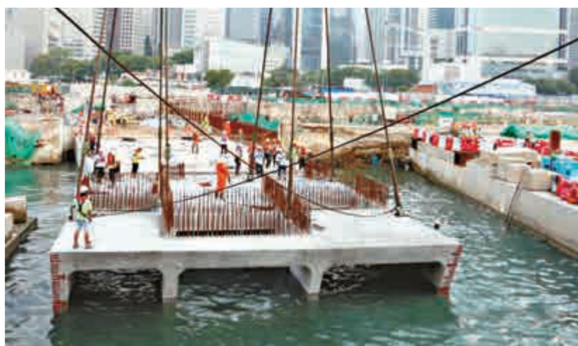
▲上月底灣仔海傍裝置了一組大型排水渠預製件，以延伸原來渠口 陳茂波網誌
