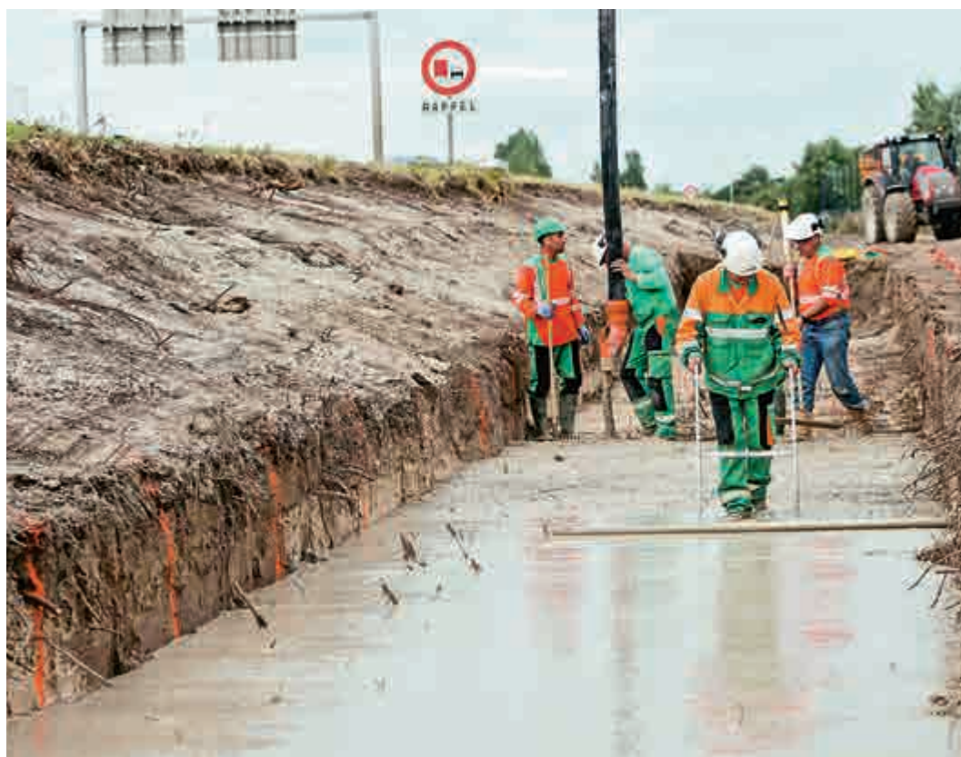
▲法工人20日在加萊工地倒水泥 法新社
