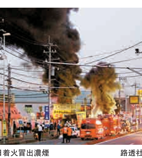
▲東電設施12日着火冒出濃煙 路透社
