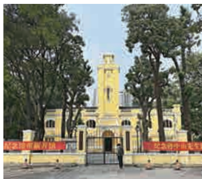
▲完成修繕後的中國國民黨一大舊址 大公報記者黃寶儀攝
