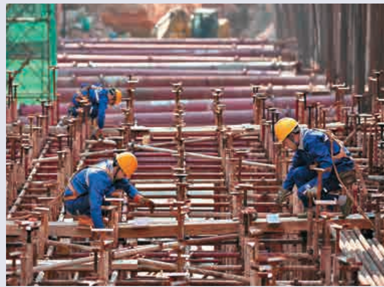
▲東部過境高速連接線施工進展已近半
