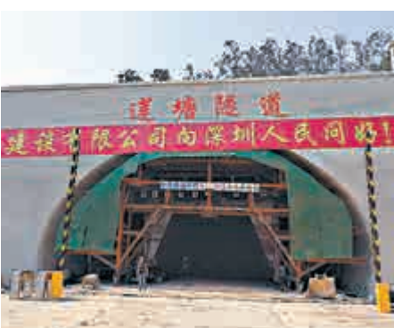
▲正在建設中的東部過境高速地下隧道
