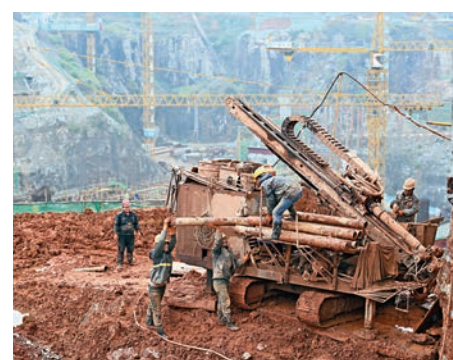
▲3月10日，湖南長沙一個滑冰場地項目建設現場
