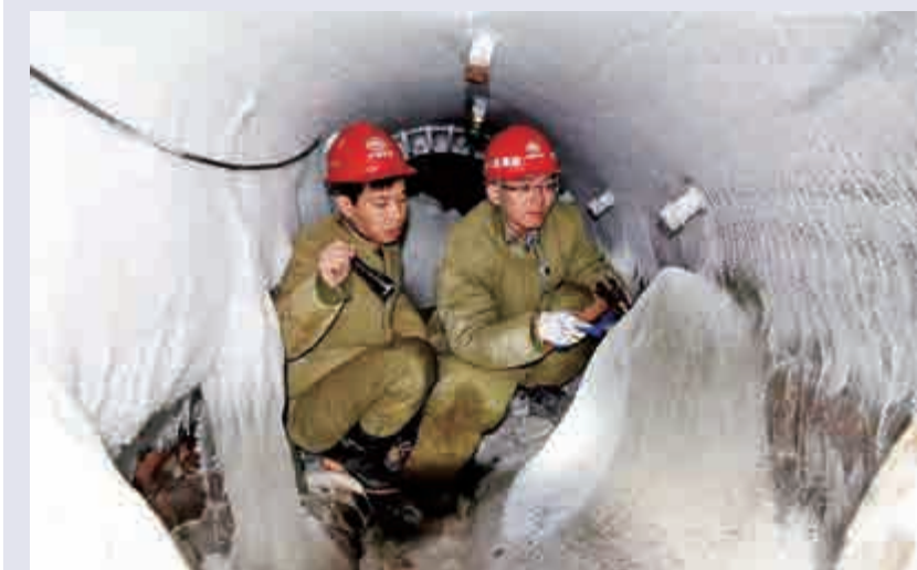
▲拱北隧道是全球首採「超大曲線管幕+超長凍結法」施工的公路隧道。圖為參建員工在零下近30度的管幕內作業 網絡圖片
