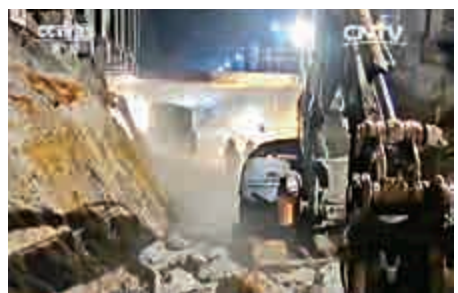
▲隧道施工現場 視頻截圖
