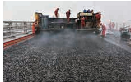
▲27日，港珠澳大橋主線瀝青鋪裝完成。圖為施工人員在橘紅色的防水層上鋪設澆築式瀝青 網絡圖片
