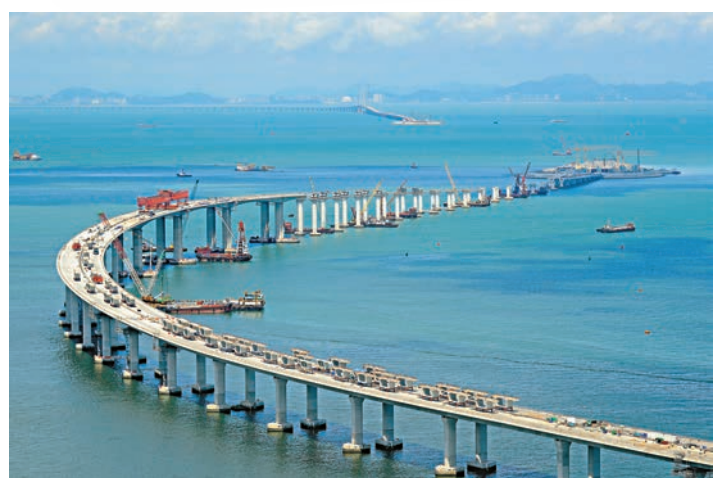
▲粵港澳大灣區建設帶來新機遇，香港作為「超級聯繫人」前景廣闊。圖為建設中的港珠澳大橋 新華社
