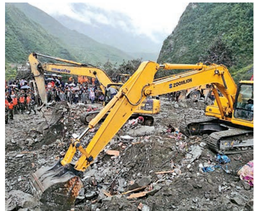
重型機器挖掘
