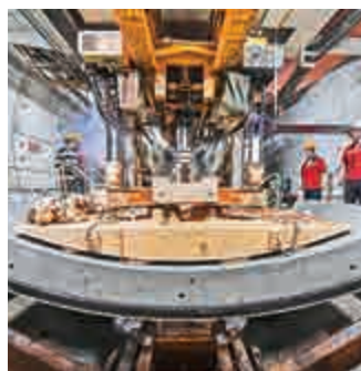
▲建設中的廣東佛莞城際軌道交通隧道 資料圖片
