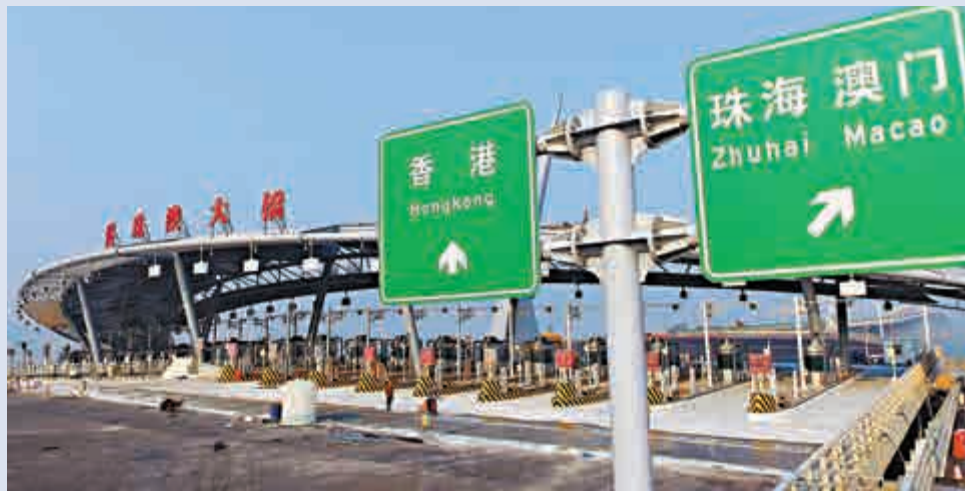
▲港珠澳大橋主體工程已具備通車條件 資料圖片
