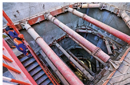
▲北京GDP達2.8萬億。圖為施工人員 在北京地鐵12號線車站作業 中新社
