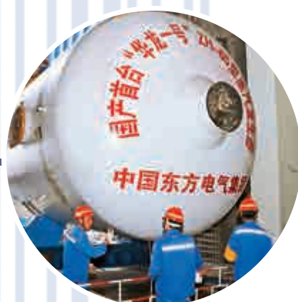
▲「華龍一號」蒸汽發生器吊入核電反應堆廠房 資料圖片
