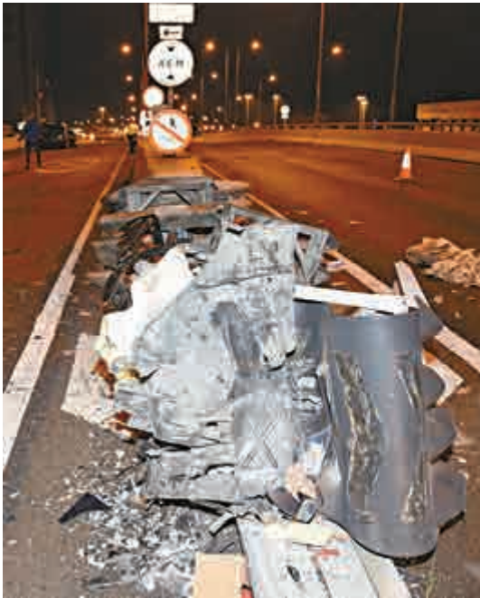
▲分隔路中的風琴式防撞欄被撞得支離破碎
