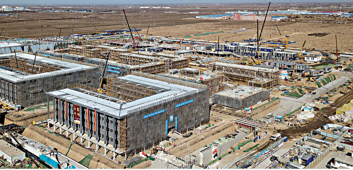
▲ 二月二十二日拍攝的雄安市民服務中心施工現場
