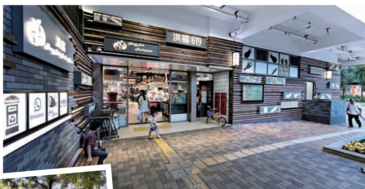
▲▼洪福邨的公共運輸交匯處採用半露天鋼齒形隔音上蓋，商場則採用長廊式商店街設計
