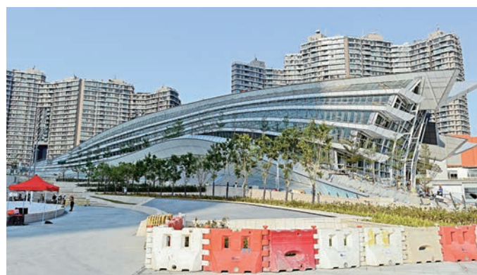
▲高鐵西九龍總站工程大致完成，大公報記者林良堅攝
