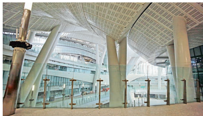
▲西九龍站中庭的幕牆以四千多塊不同形狀玻璃組成
