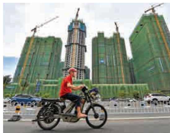
▲海口市一個大型住宅項目正在施工 資料圖片
