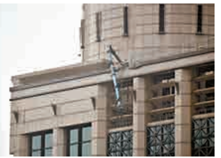
▲利舞臺廣場天台吊臂疑不勝負荷摺曲，導致巨型環保斗墮街
