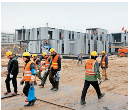
▲ 在雄安市民服務中心施工工地，工人們在交接班 大公報記者顧大鵬攝
